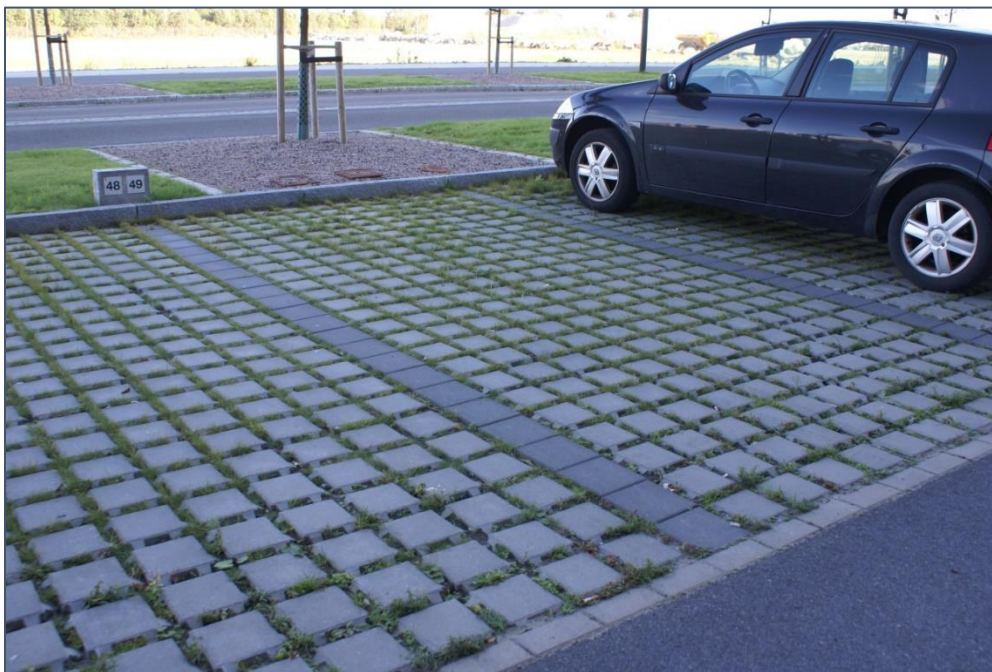
Figur 2. Parkeringsyta med genomsläpplig beläggning i form av gräsarmering (Foto: Norconsult)
