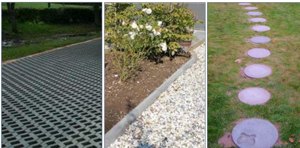
Figur 1. Yta med hålsten av betong, makadambelagd gång, samt gångstig med gräs och några gångplattor i betong (Foto: Norconsult)
