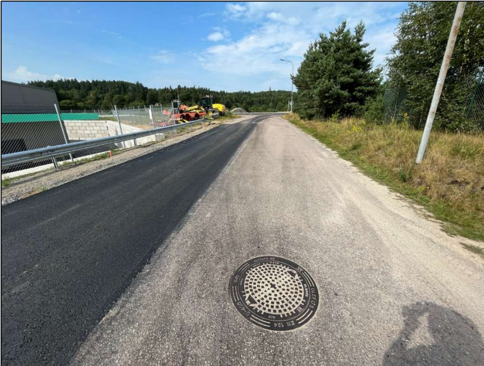
Figur 17. Dagvattenbrunn för befintligt dagvattensystem söder om planområdet (Foto Norconsult).
