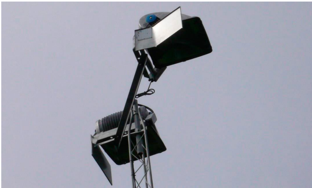
Figur 4: Samma armatur som Mölnlyckeens IP med mekanisk avskärmning.
