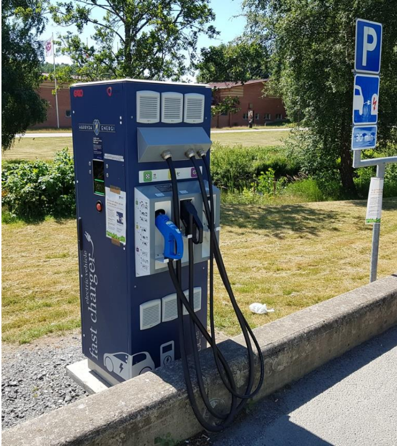
Figur 8: Snabbladdare i Mölnlycke C. Skyltning anpassad efter tiden det tar för att ladda fullt samt skylt som visar att laddningen är publik.
