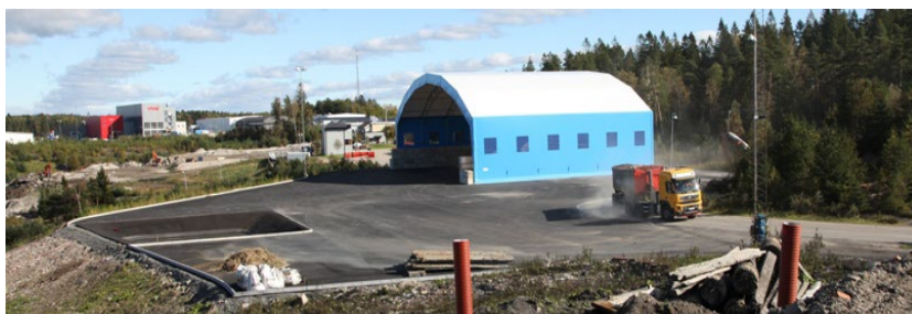
Figur 4-1. Exempel från befintlig verksamhet med yta för mellanlagring av avfall med tält som nederbördsskydd.
