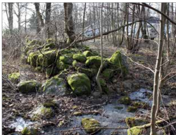
Figur 15. Stenvmur (nr 206) inom Göskulla 3:2. En öppning har gjorts för att släppa fram en liten bäck.
