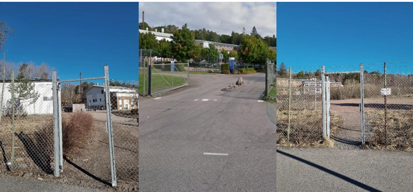
Figur 8. Bilder på skolans entréer och stängsel som inhägnar fastigheten. (AFRY & Google maps street view)
