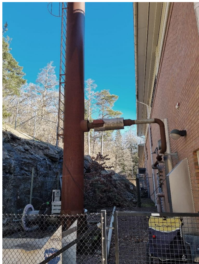
Figur 19. Baksidan bakom den västra delen av skolbyggnaden.
