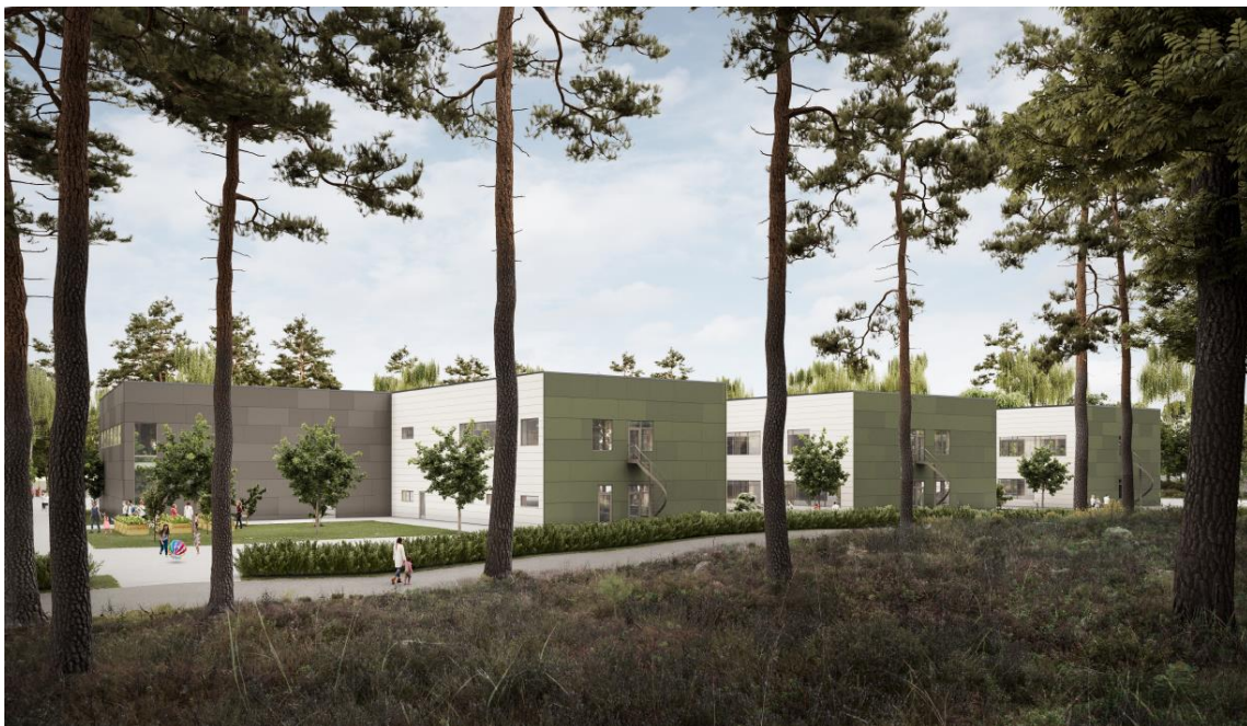
Figur 10 Visionsbild som visar den nya skolans västra fasad, sedd från naturområdet vid Furuhällsskolan. De nya skolans gymnastiksal syns till vänster i bilden.
