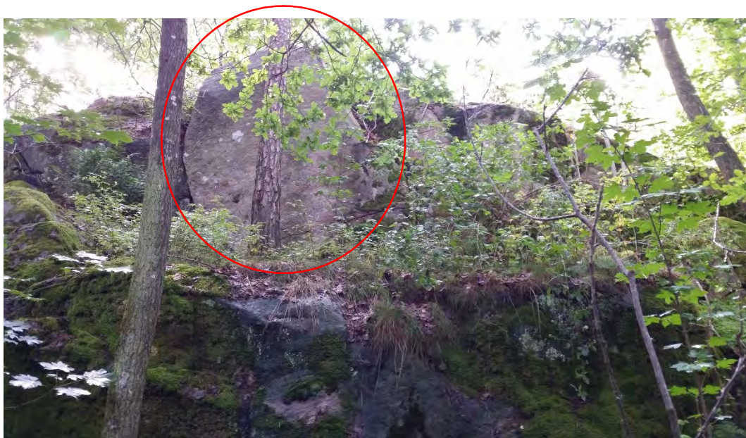
Figur 6 Lösa block och mycket vegetation vid ID 4
