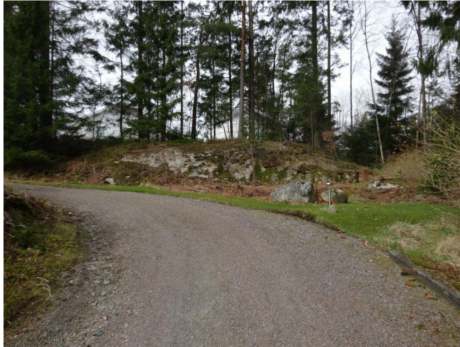
Bild 20 tagen mot nordväst på berg i dagen från sydöstra delen där en grusväg finns.
