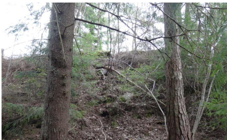
Bild 23 tagen mot nordost upp mot stenvuren från den lägre terrängen i sydväst. Stenvuren bör tas bort i samband med exploatering då lösa block förekommer.
