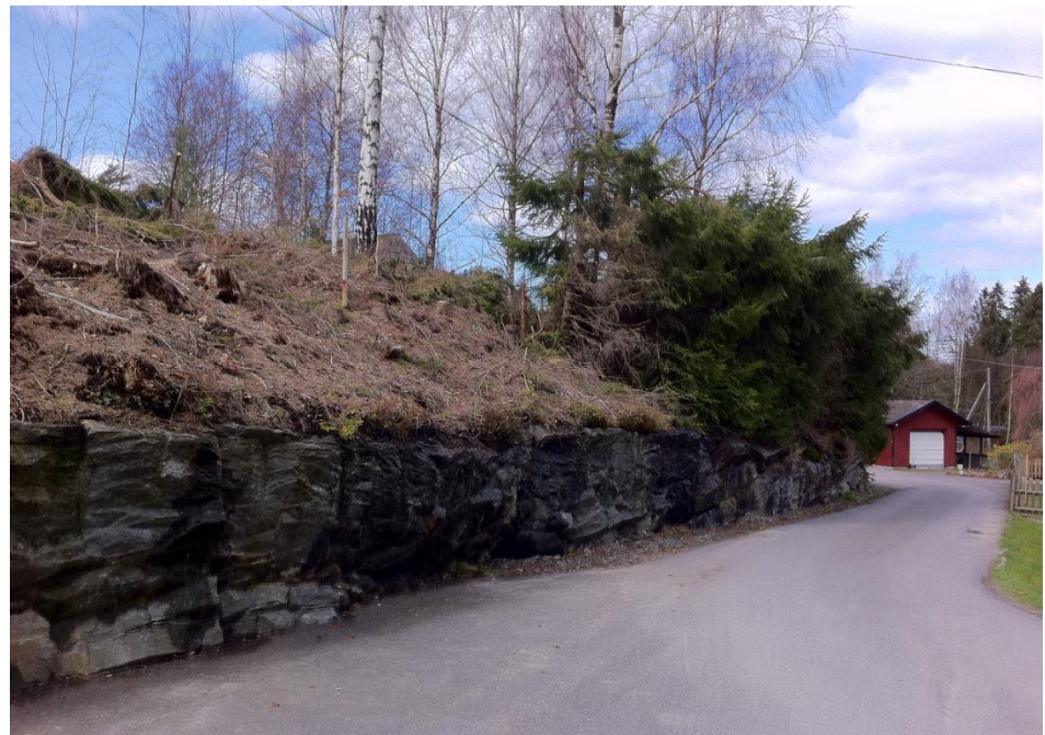
Bild 11 tagen mot norr längs med gatan med vertikal bergskärning.
