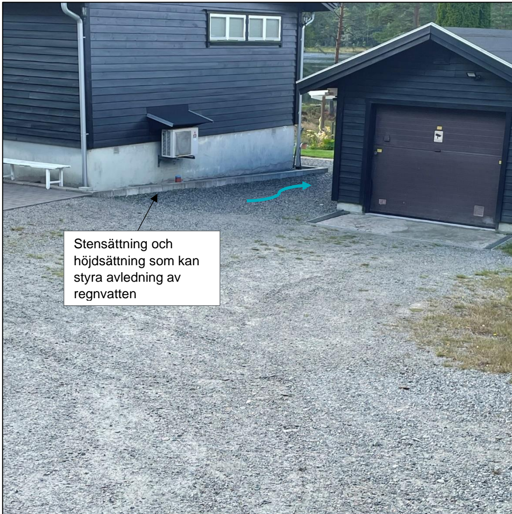
Figur 14. Stensättning och höjdsättning vid byggnation vid Ärlevägen som kan styra avledning av regnvatten. Foto: Norconsult.
