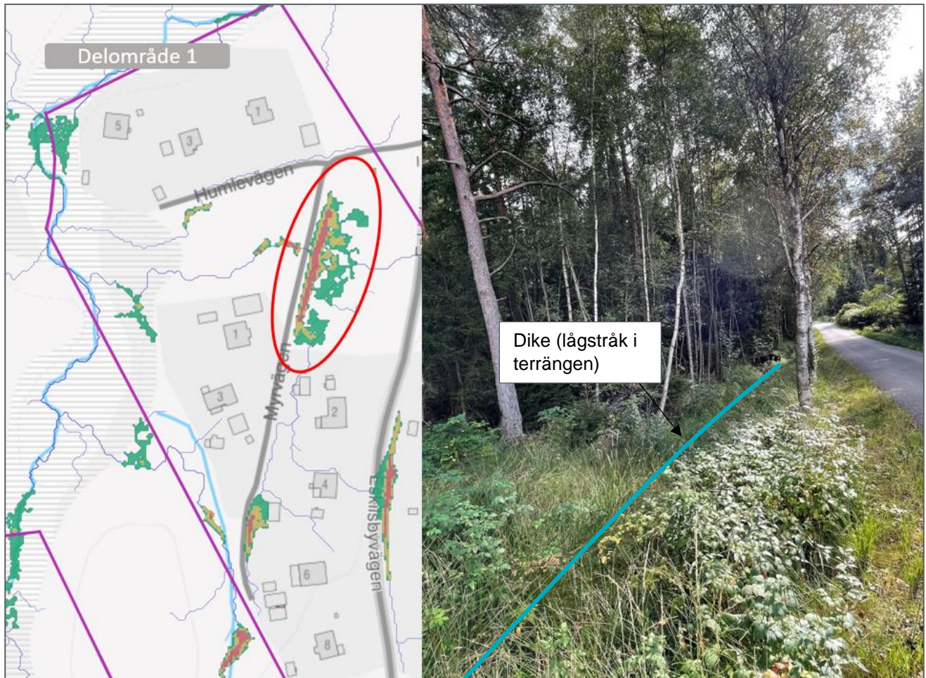
Figur 8. Lågpunkt längs med Myrvägen, se område markerat i rött (SCALGO, 2022) Foto: Norconsult.
