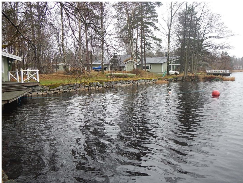
Foto 5. Erosionsskydd i form av uppbyggd mur längs västra delen av Bocköhalvön, vy mot söder.
