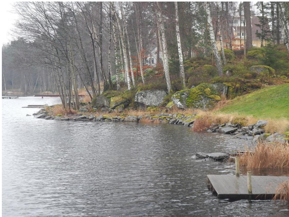
Foto 3. Erosionsskydd i form av block längs östra delen av Bocköhalvön, vy mot söder.
