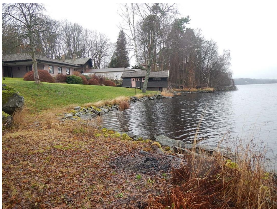
Foto 4. Erosionsskydd i form av block längs östra delen av Bocköhalvön, vy mot norr.
