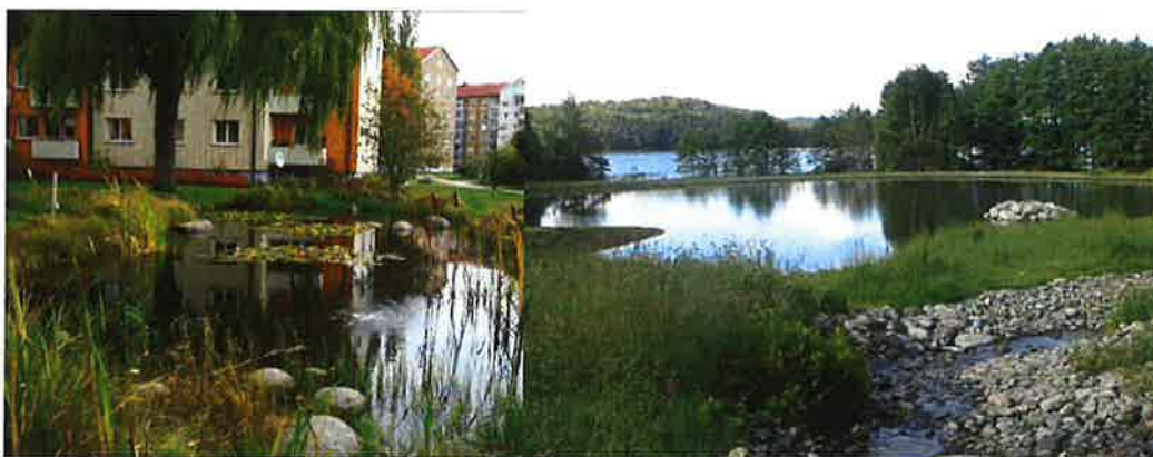
Figur 18. Exempel på dagvattendammar med permanent vattenyta.
