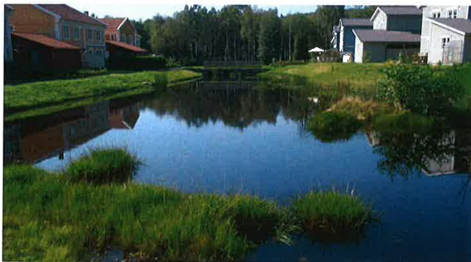
Figur 4. Dagvattendamm i bostadsområde (Landvetter, Önneröd).
