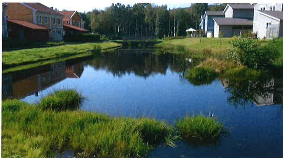
Figur 4. Dagvattendamm i bostadsområde (Landvetter, Önneröd).
