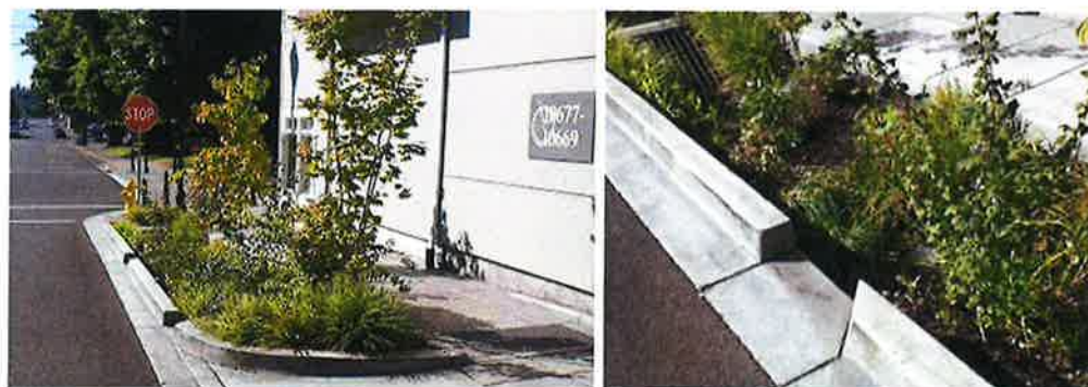
Figur 10. Kantstenslösningar. I bilderna visas att övergången mellan gångbana och växtbädd kan skapas utan kantsten och att kantsten med släpp anläggs i övergången mellan väg och växtbädd.
