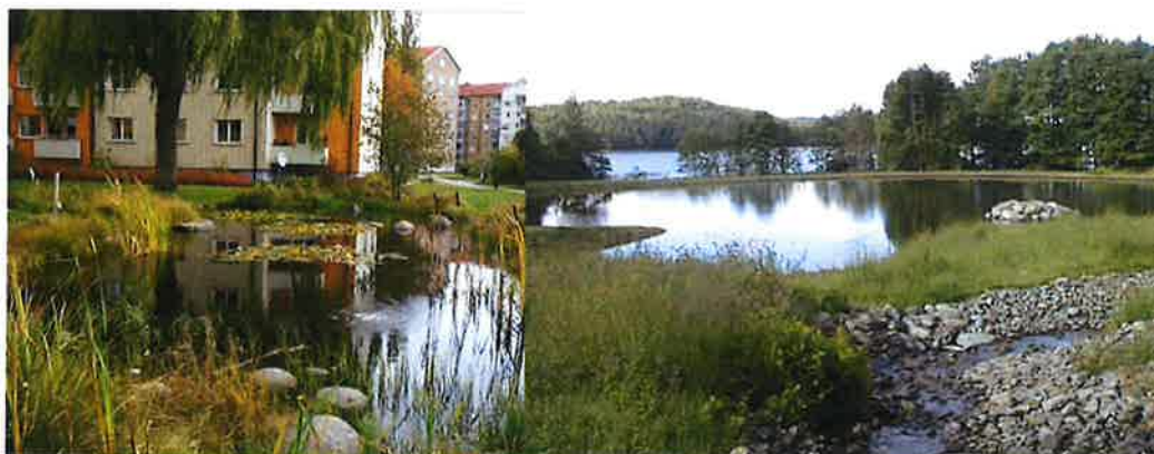
Figur 18. Exempel på dagvattendammar med permanent vattenyta.
