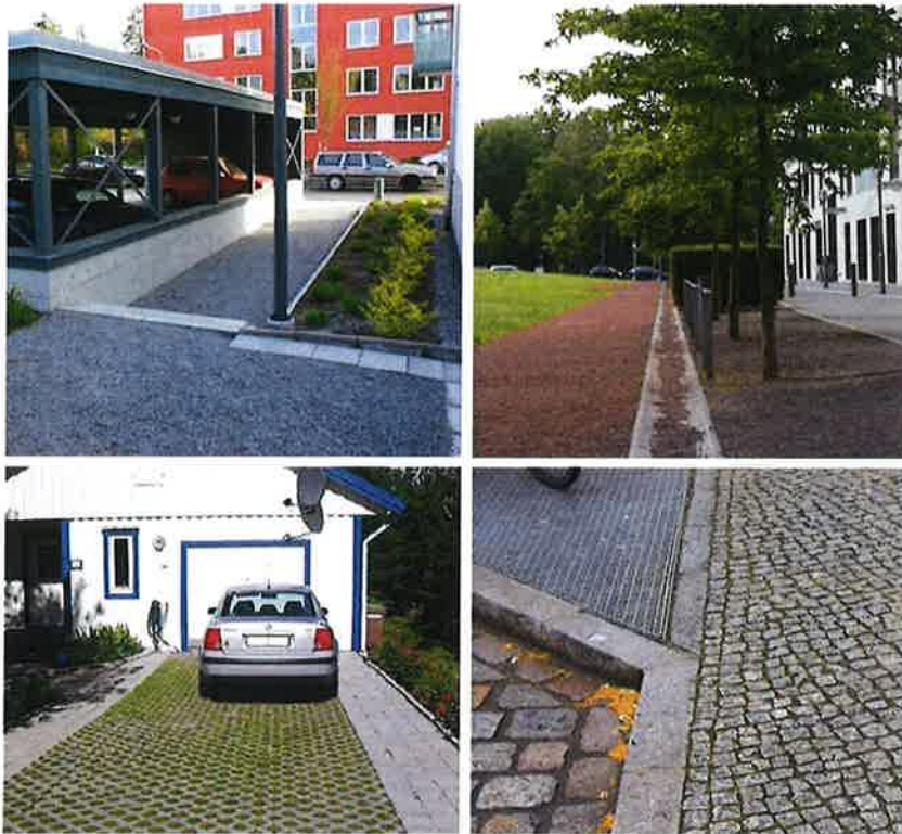
Figur 8. Exempel på genomsläppliga beläggningar.
