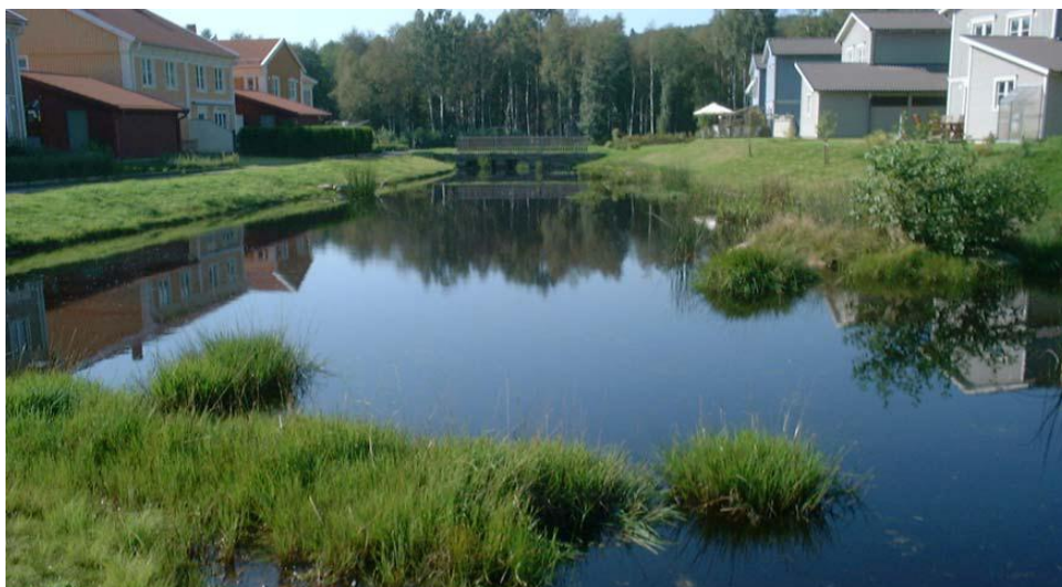
Figur 4. Dagvattendamm i bostadsområde (Landvetter, Önneröd).
