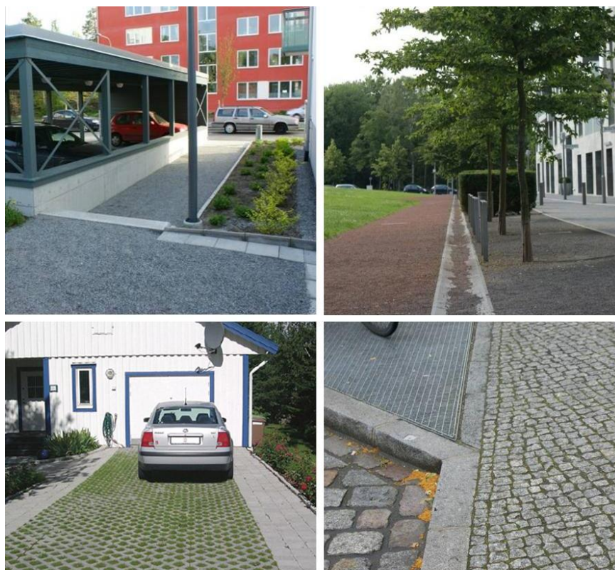
Figur 8. Exempel på genomsläppliga beläggningar.
