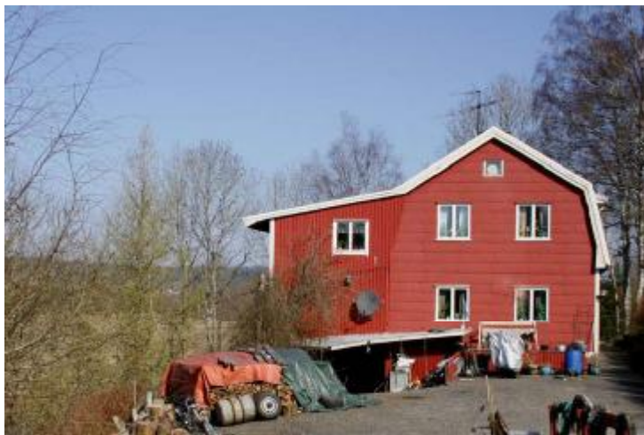
(Figur 15) Snickeribygnaden står fortfarande kvar på sin strategiska plats mellan landsvägen och Storån som var snickeriets kraftkälla. En turbin drev maskinerna med hjälp av remdrift.
