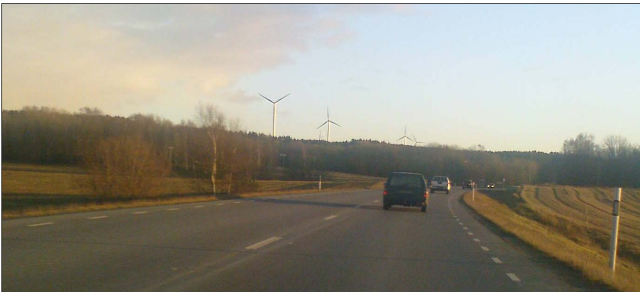
Figur 8. Befintlig vindkraftanläggning i Hud, Tanums kommun med sex vindkraftverk med en effekt på 2,5 MW och en totalhöjd på 135 meter.
