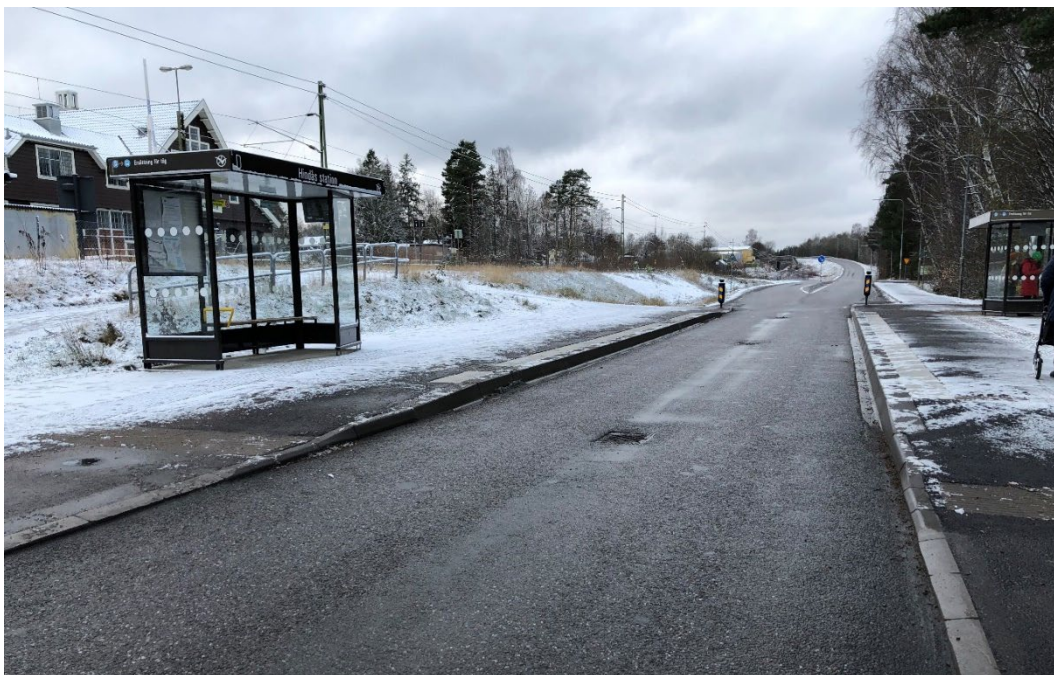
Figur 6. Busshållplats Hindås station, på Boråsvägen. Foto taget ifrån öster.
