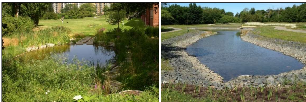
Figur 22. Till vänster dagvattendamm vid Augustenborg, till höger dagvattendamm i Trönninge i Varberg (Foto: Norconsult).
