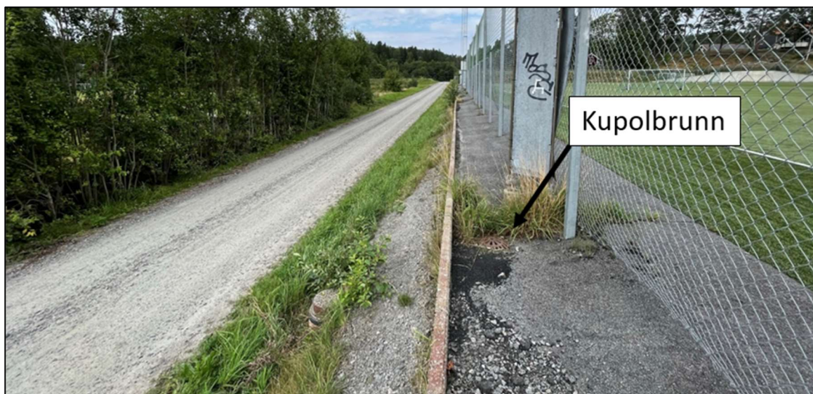
Figur 15. Konstgräsplanen avvattnas via kupolbrunnar.
