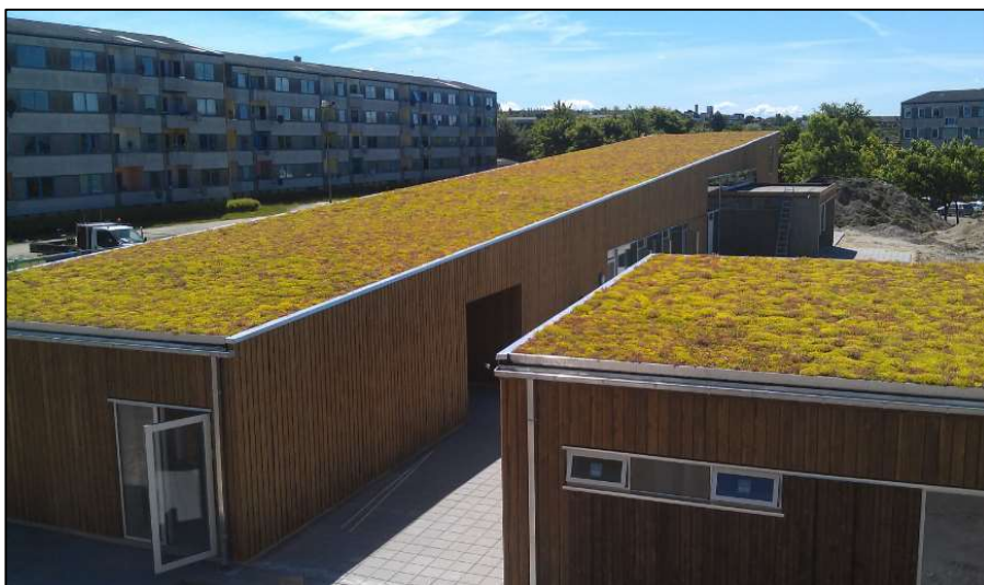
Figur 23. Exempel på sedumtak (Källa: Engman Tak AB)
