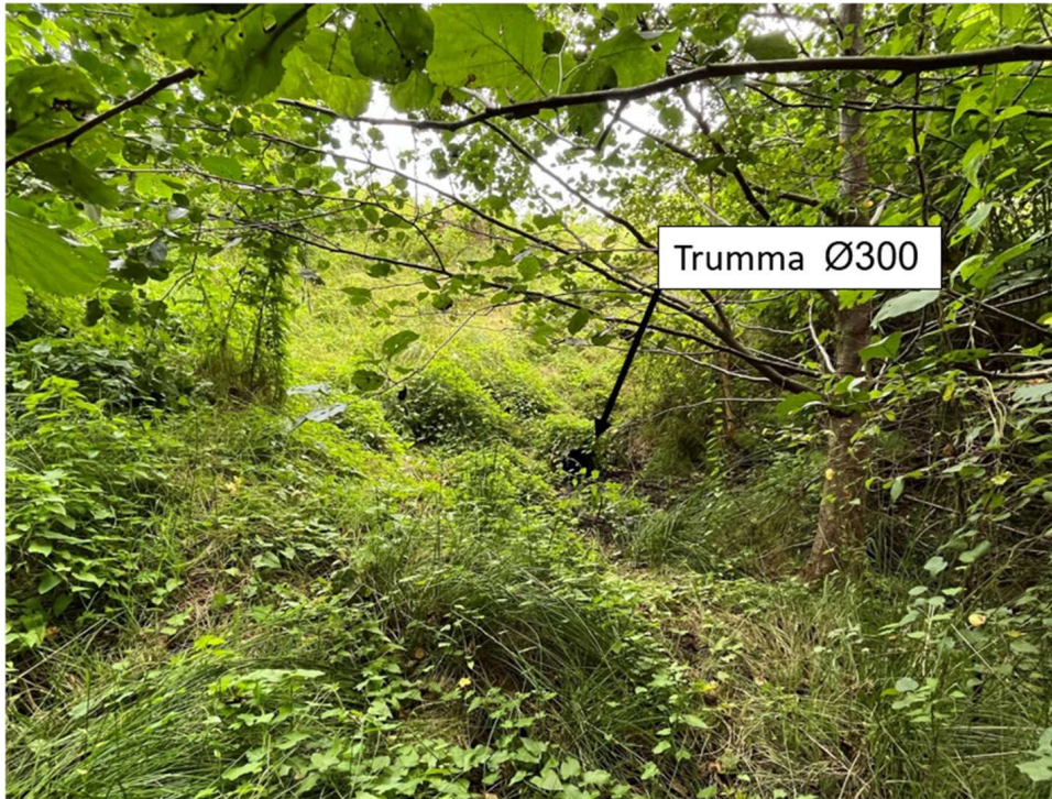
Lågpunkt i norra delen där vatten samlas vid skyfall. Dagvatten- och skyfallsutredning del 1 Norconsult.
