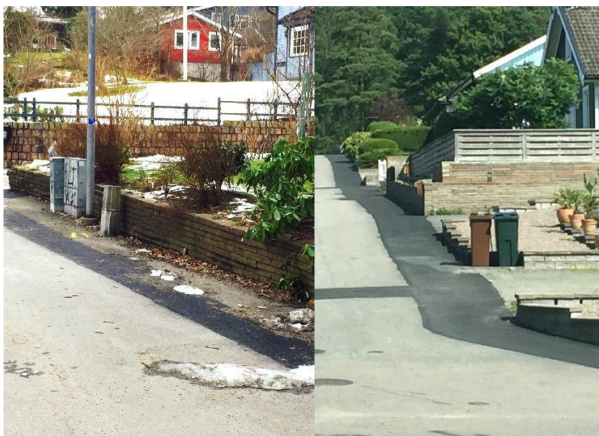
Figur 3 Klargörande av yta C enligt Figur 2. Bild till vänster visar ett underkänt utförande. Bild till höger visar ett exempel på ett godkänt utförande vad gäller hantering av kvarvarande yta C. Asfalten har i den högra bilden anslutits mot murar och fastigheternas infarter på korrekt sätt.
