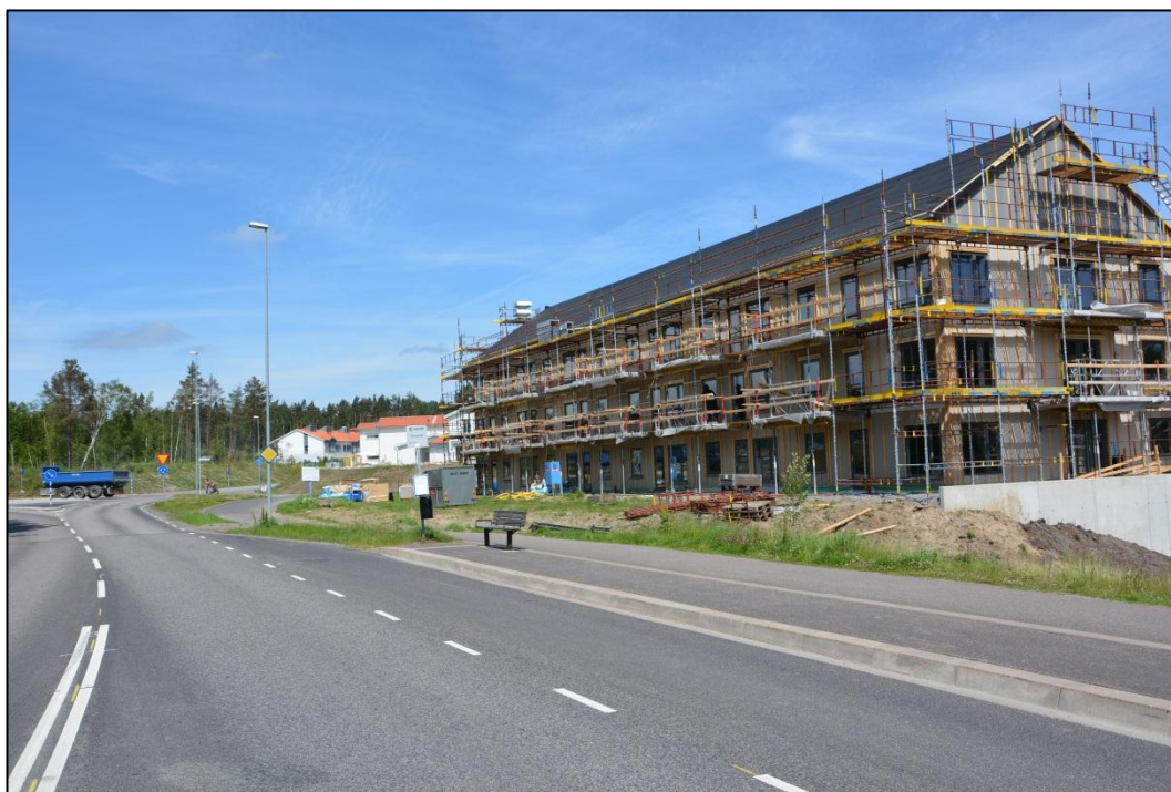
Figur 20 Hållplats Önneröd med byggnation av hyresrätter
