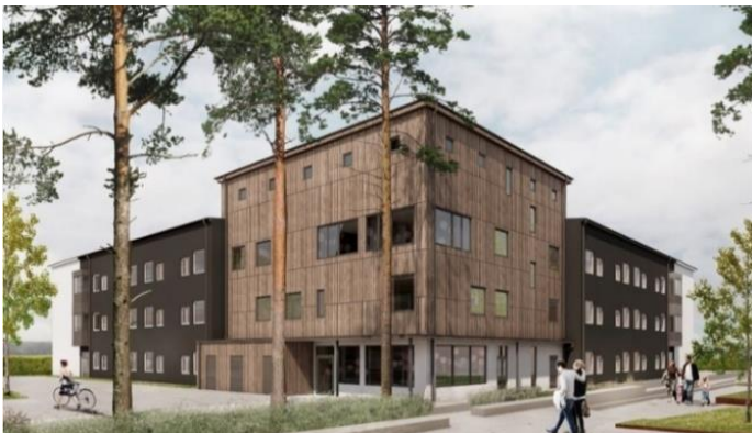
Byggnaden sett från torget i pågående projekt Sölvesborg
