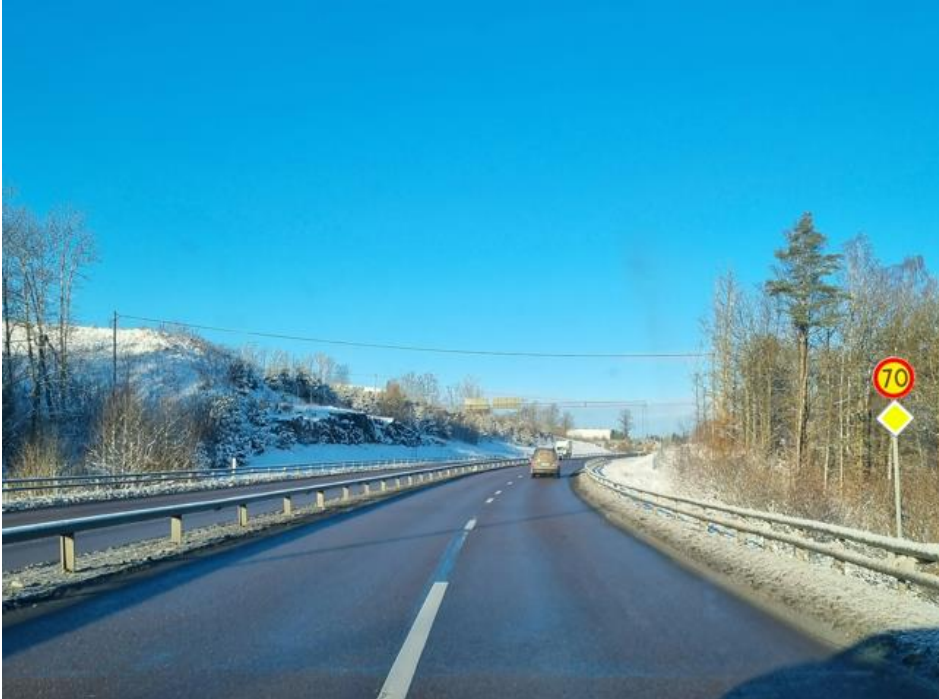
Figur 9. Väg 535 utgörs av 2+2-väg med räckesseparering mellan Bårhultsmotet och cirkulationsplatsen vid Fläskebovägen
