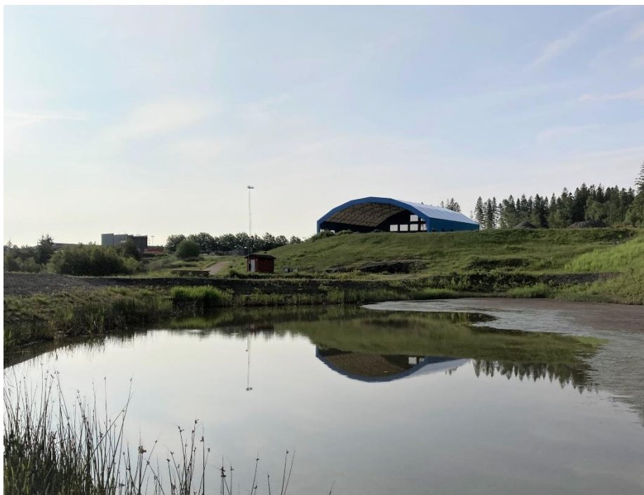
Figur 3. Lakvattendamm inom deponiområdet.
